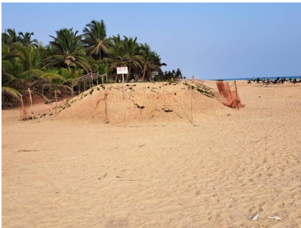
Photo 5: Digue de sable mise en place à Aného
