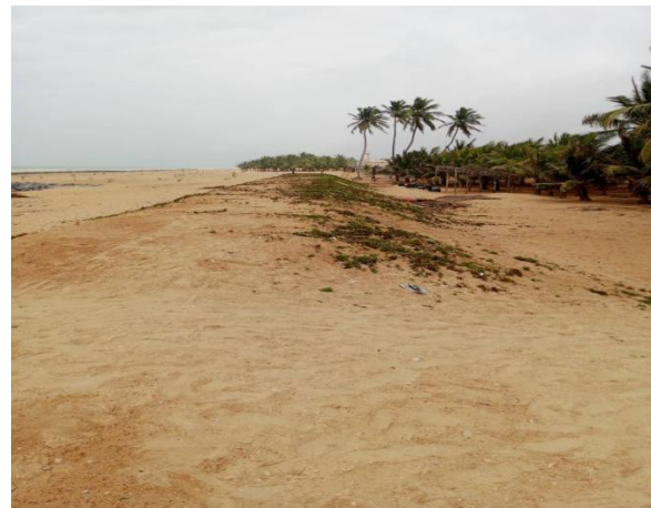
Photo 5: Digue de sable mise en place à Aného
