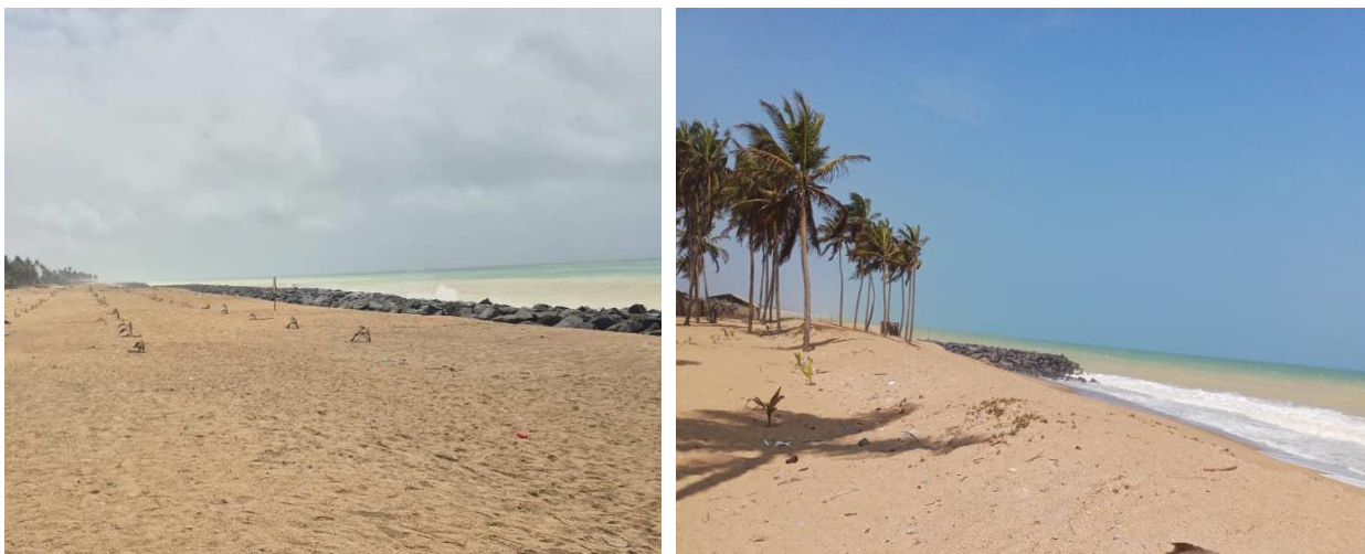
Photo 3: Aperçu de quelques épis réhabilités
