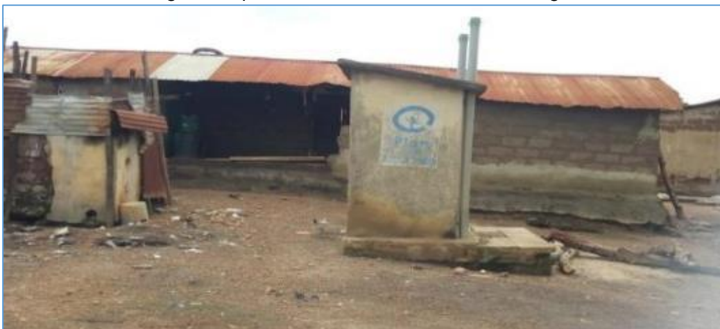
Photo 7 : WC public à Kamina
