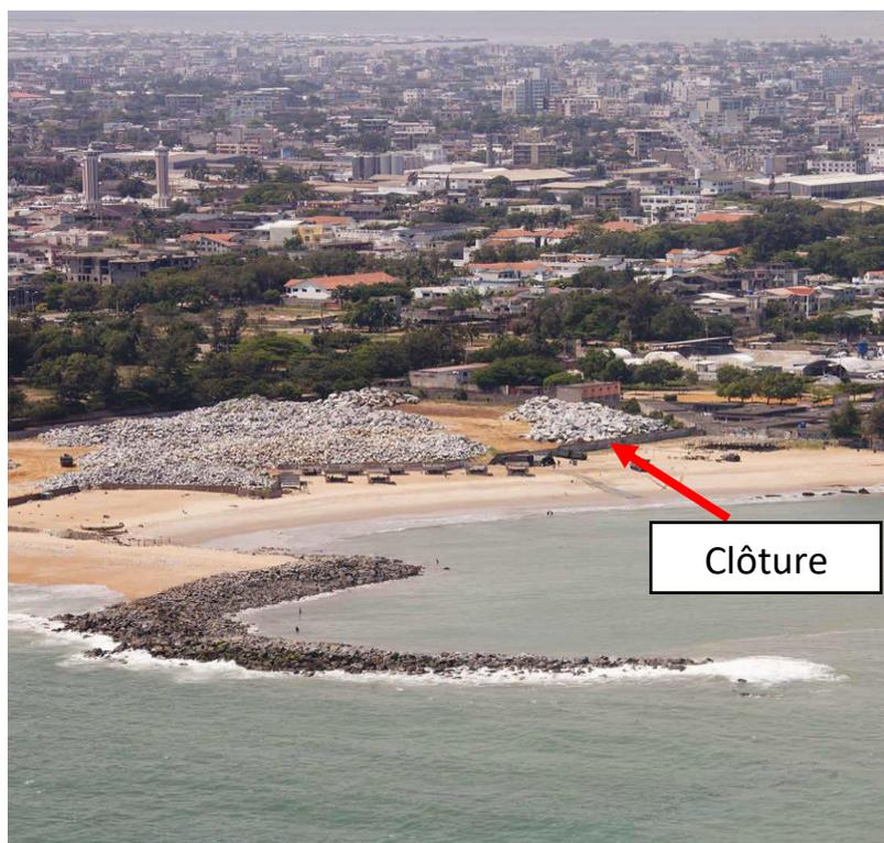
**Photo 33** : Exemple de zone de stockage d'énrochement sur un chantier de construction d'épis au Bénin
