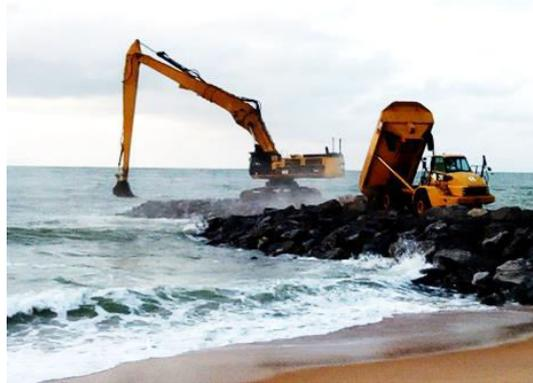
**Photo 26 :** Exemple de construction d'un épi à Cotonou
